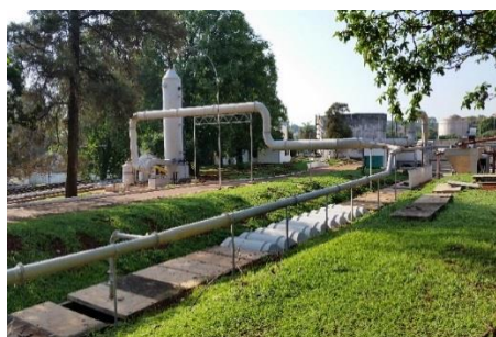
Figura 5.8 – Melhorias Operacionais realizadas nas ETES Sul e Norte
