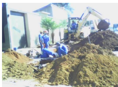
Figura 5.7 – Ligações de esgoto executadas em Vicente Pires
