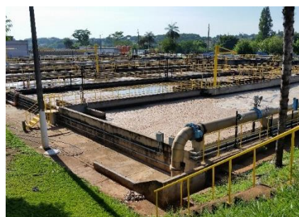
Figura 5.9 – Melhorias Operacionais realizadas nas ETES Sul e Norte
