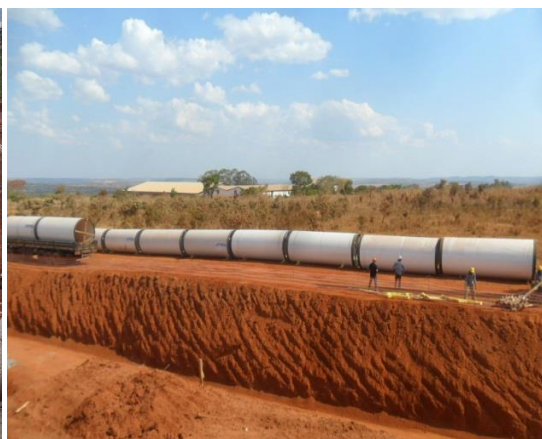
Figura 2.2 - Adução de Água – Sistema Corumbá
