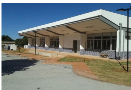
Figura 5.6 – Novo Laboratório de Macromedição
